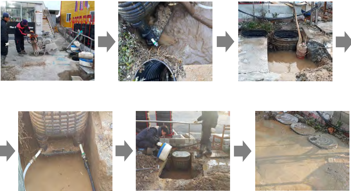
[Open Trench Replacement - Fittings, PE D16 mm]
