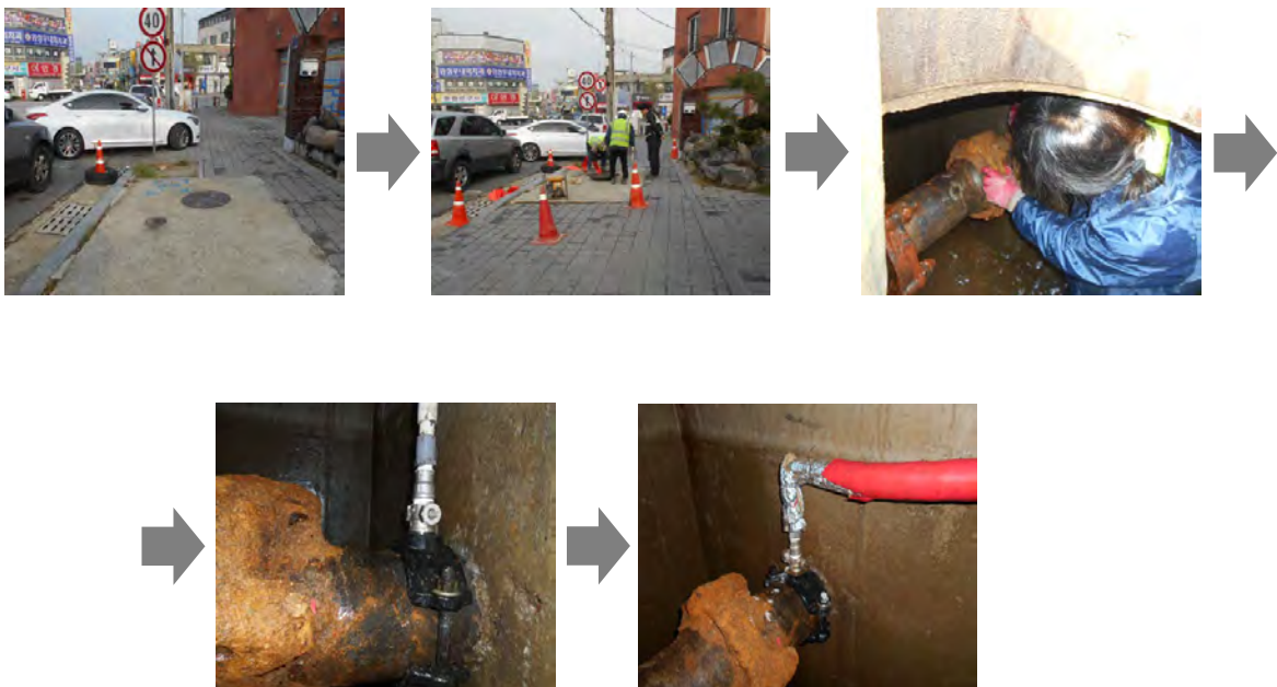
[Open Trench Replacement - Saddle, DCIP D150 mm × XLPE D16 mm]
